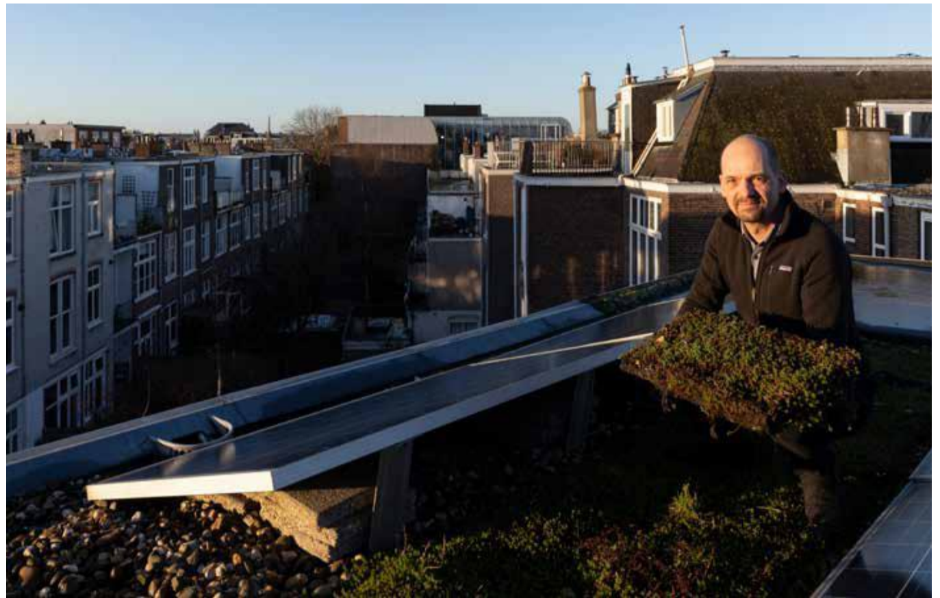
Jelle de Jong op zijn dak met sedumkurk-cassettes: 'Het dak is in de zomer al 10 graden koeler'.
