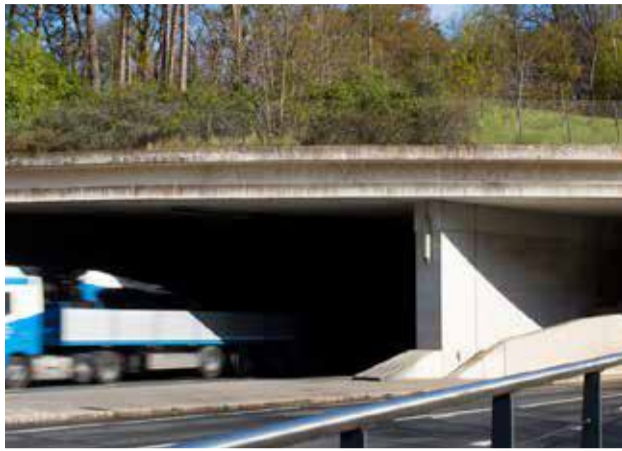
De Hubertustunnel is toe aan renovatie.
