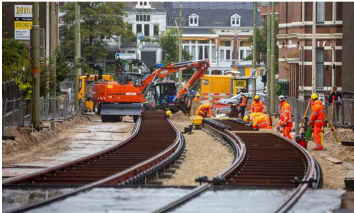
Het spoor bij de Duinstraat wordt aangepast voor de nieuwe toegankelijke tram.
