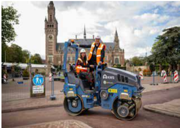
Aanleg fietspad Carnegieplein.
