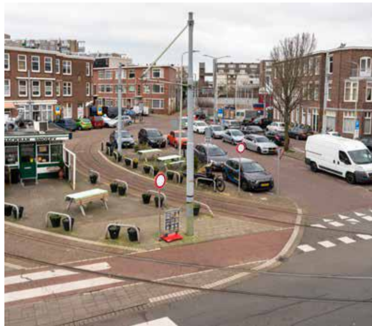
Het riool wordt vervangen en de openbare ruimte opgeknapt.
