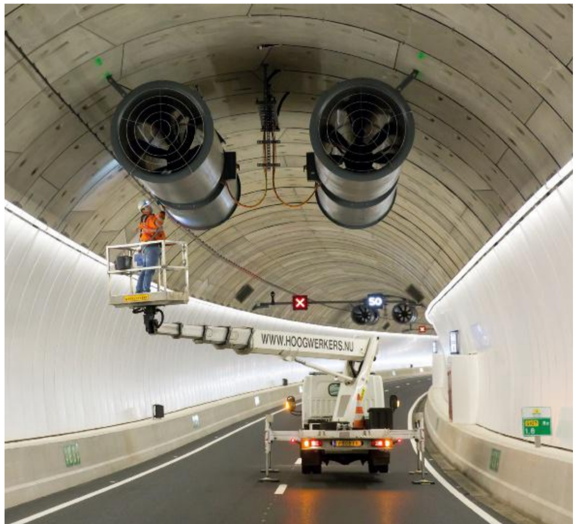
Een medewerker voert enkele laatste werkzaamheden uit aan ventilatoren in de Victory Boogie Woogietunnel. JURRIAN BROBBEL
