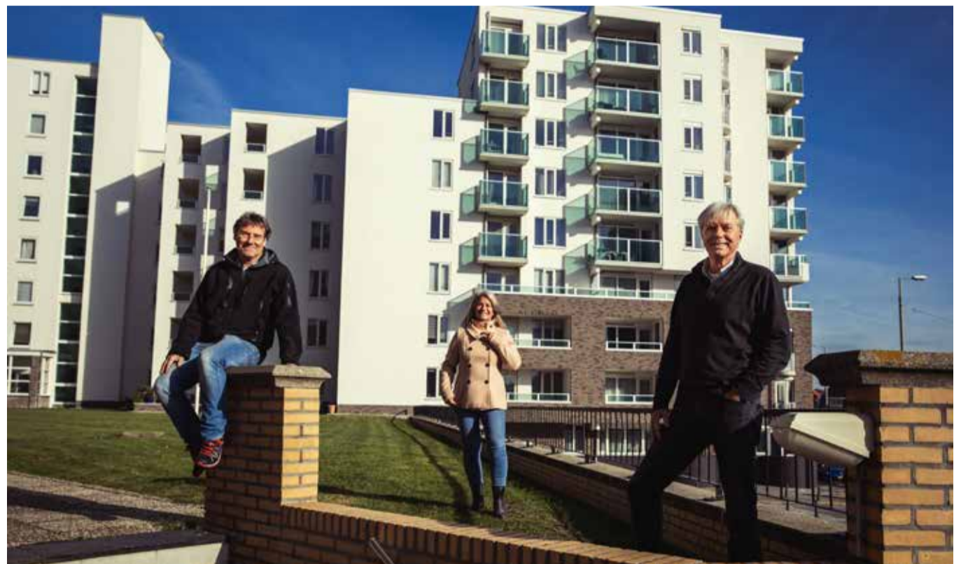
Bewoners van het Energieteam Zeekant zijn gestart met de overstap naar een duurzame warmtebron voor hun wooncomplex.
