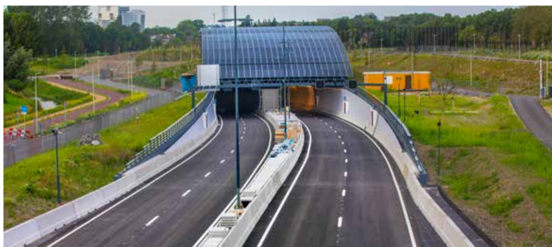
De Binckhorstlaan na herinrichting (boven) en de toerit van de Victory Boogie Woogietunnel in de Vlietzoom.
