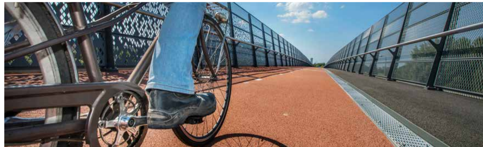
Het nieuwe Jan Linzelviaduct over de A4 en het fietspad door de Vlietzoom zijn samen onderdeel van de snelle fietsroute tussen Ypenburg en Den Haag centrum.
