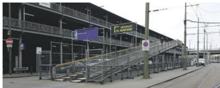
De toegang van de fietsflat aan de Rijnstraat wordt opgeknapt.
