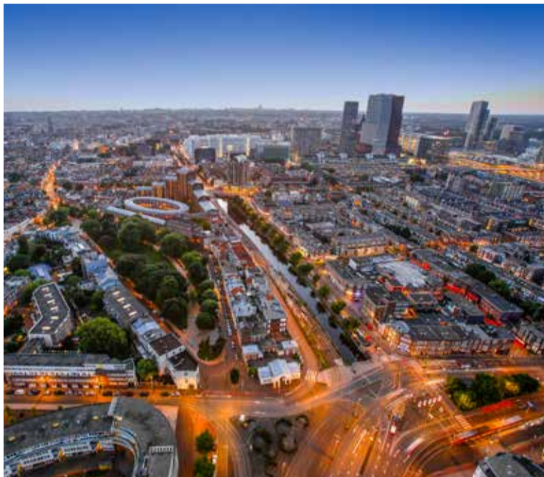
De woningen in Den Haag zijn gemiddeld 13% in waarde gestegen.
