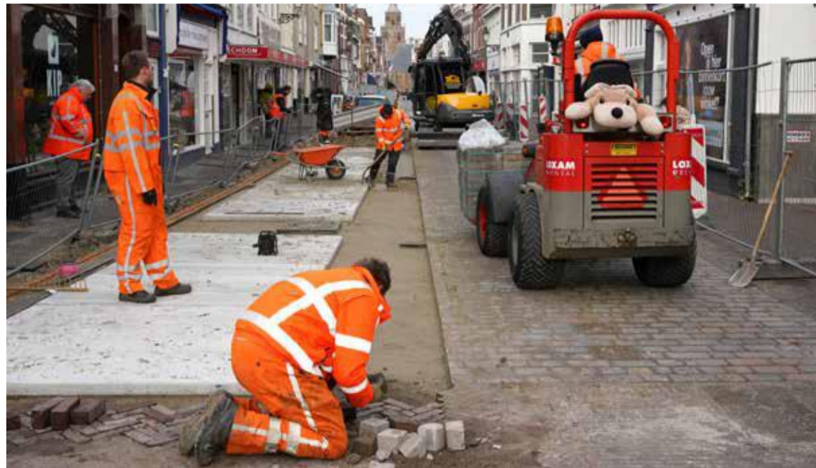
Werkzaamheden in de Keizerstraat.
