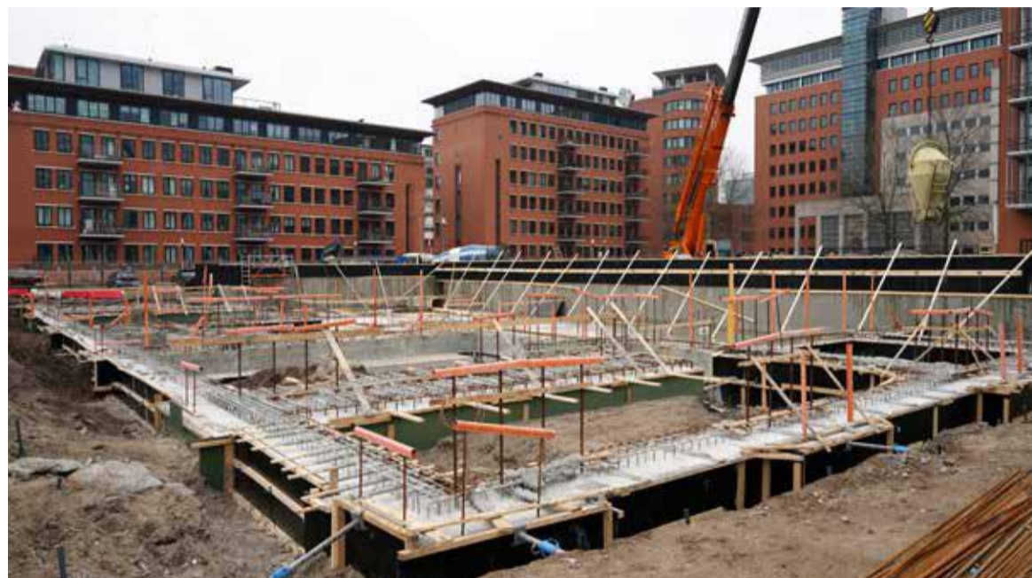
Bouwproject op de Binckhorst.
