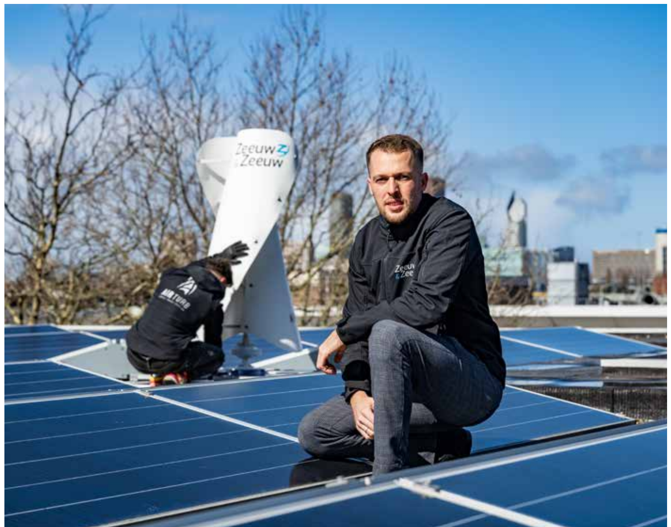
Facility manager Jelle Beekhuis op het dak van de vestiging aan de Zonweg: ‘We halen nu energie uit lucht, zon en wind’.
