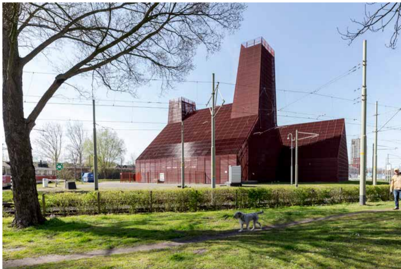
De installatie aan de Leyweg levert genoeg warmte aan het stadswarmtenet van Eneco om ruim 2.500 woningen te verwarmen.
