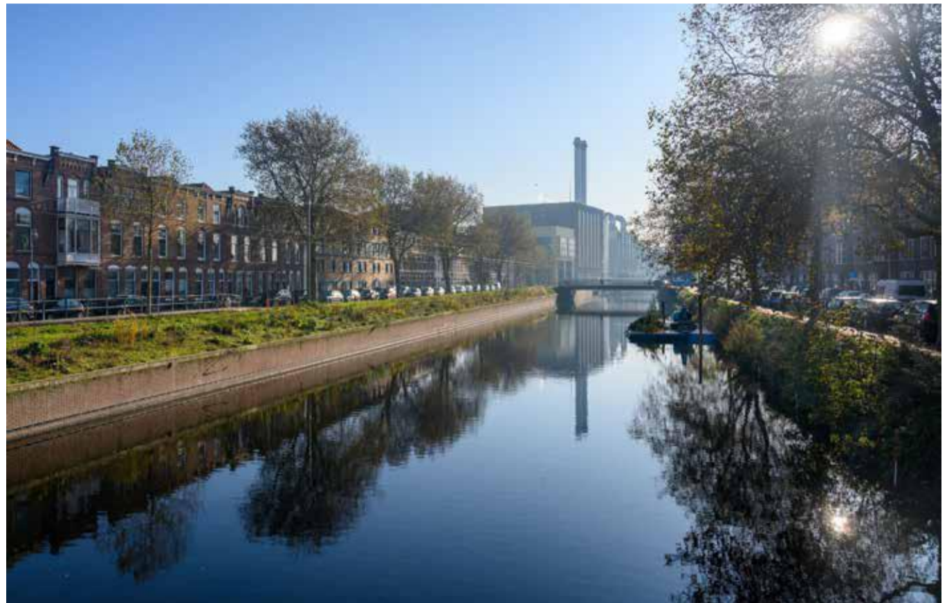
De elektriciteitscentrale aan het De Constant Rebecqueplein.
