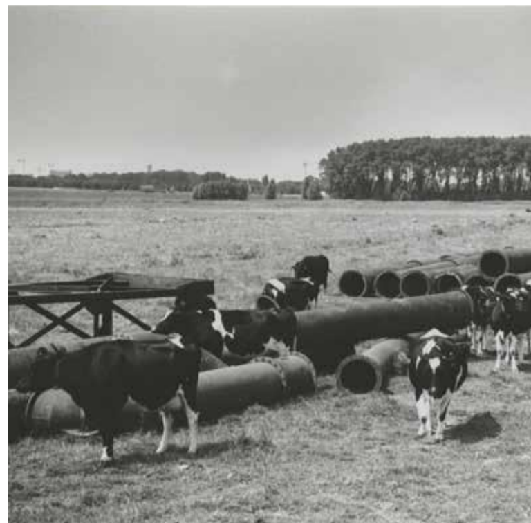
Koeien grazen (nog) tussen de rioolbuizen op de plek waar Forepark gepland is. 23 juli 1992.
