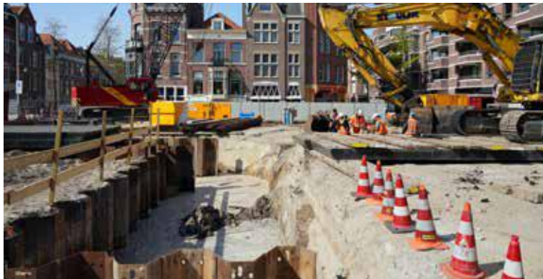
Werkzaamheden Piet Heinplein.
