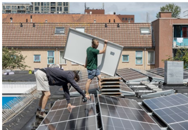
Zonnepanelen op het dak van buurtcentrum Laakhage.
