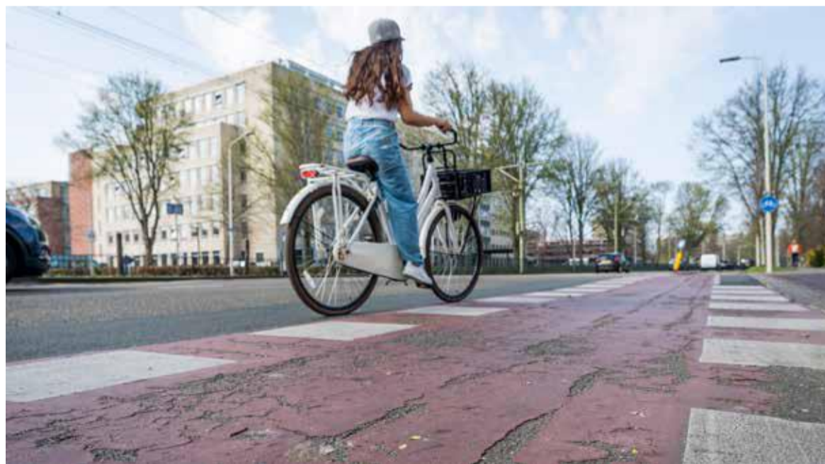
De Hofzichtlaan is een van de wegen die nieuw asfalt krijgen.
