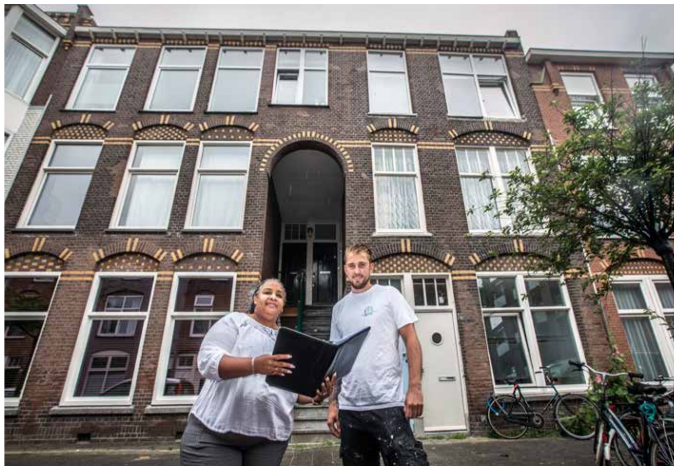
Diamela voor de VvE Mariottestraat, waar onder andere dak- en vloerisolatie wordt aangebracht.
